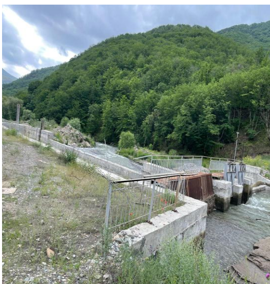
Şəkil 2. Laçın rayonu Hocasus çayı üzərində tikilmiş su qovşağı.
